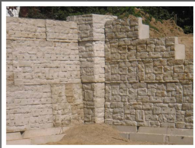
Izvedeni sistemi za odbranu od poplava i erozije tla, izgrađeni slaganjem betonskih gabiona u EU
