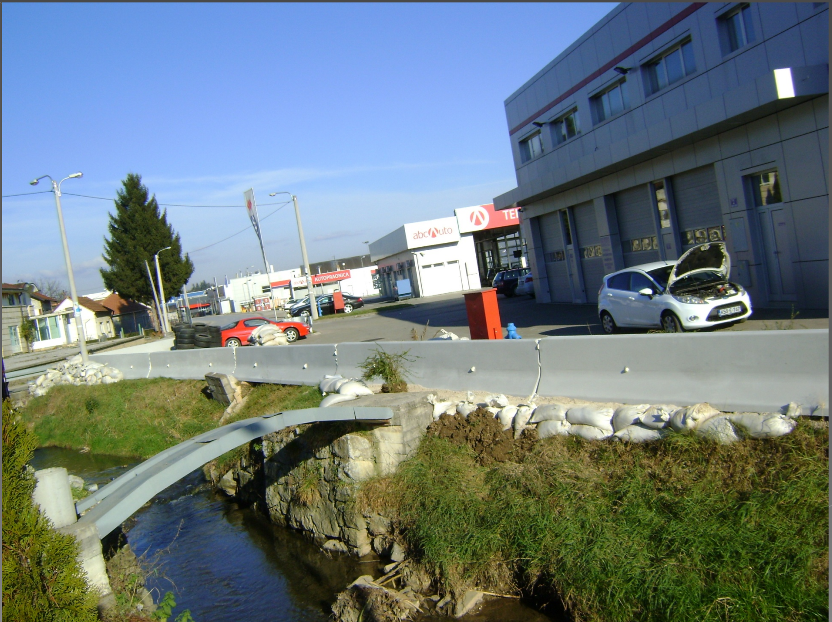
Izvedeni sistemiza odbranu od poplava, Banja Luka
