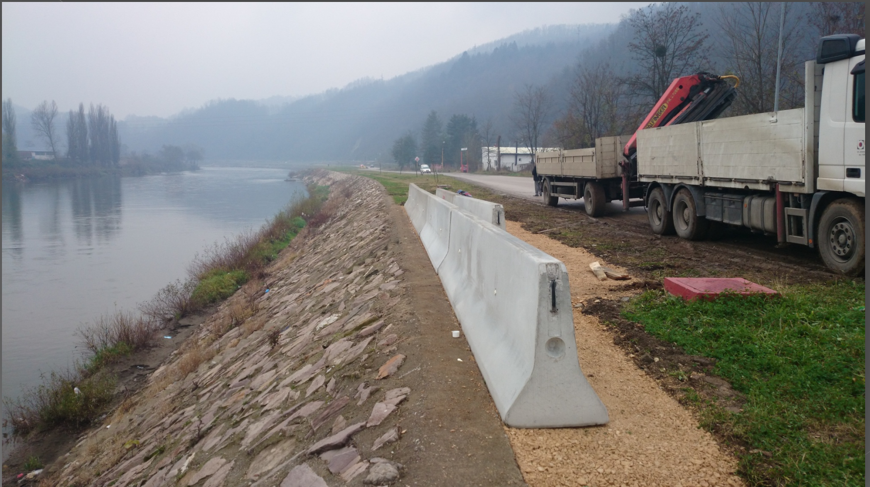
Izvedeni sistemiza odbranu od poplava, Maglaj
