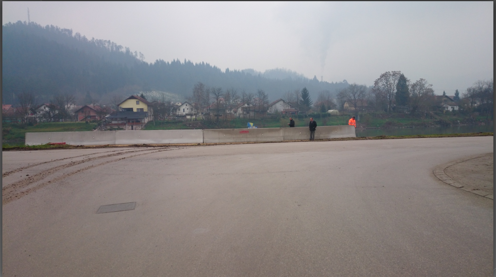
Izvedeni sistemiza odbranu od poplava, Maglaj
